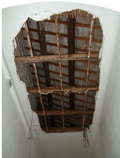
Il solaio della scuola L.Da Vinci di Castelferretti
